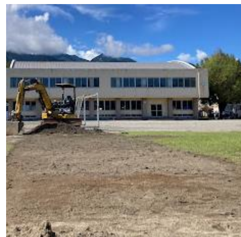
完成した「走り幅跳び走路」
